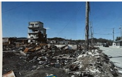
能登半島地震の被害状況
